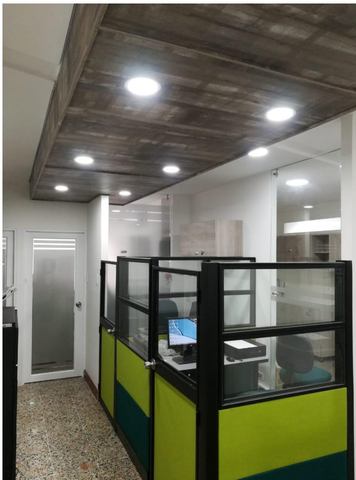
Gráfico 13. Parte del Área Administrativa de las Instalaciones
